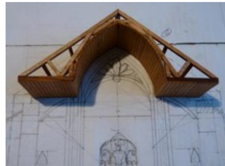
(La charpente et sa voûte en bois)
